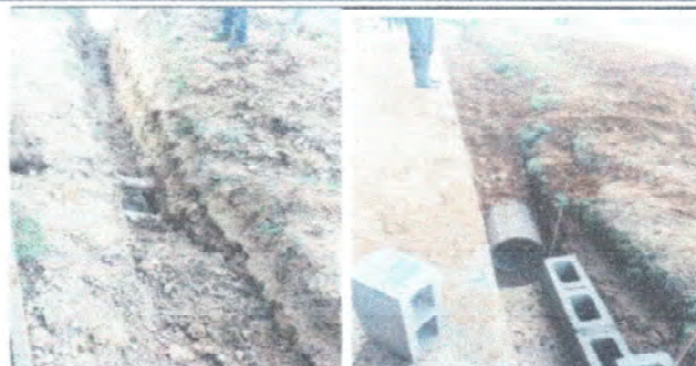
Foto 2: instalacion de cunetas de concreto para desagüe enfrente de la escuela
