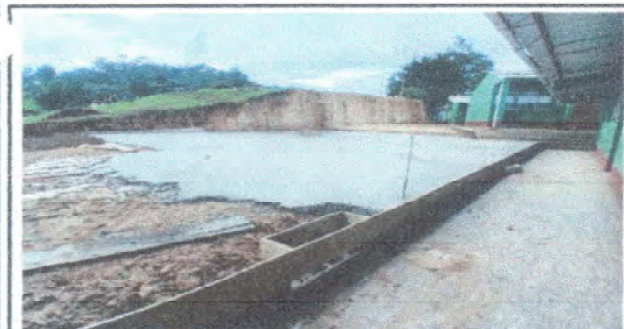
Foto 5: Trabajando el piso torta de cemento enfrente de la escuela.
