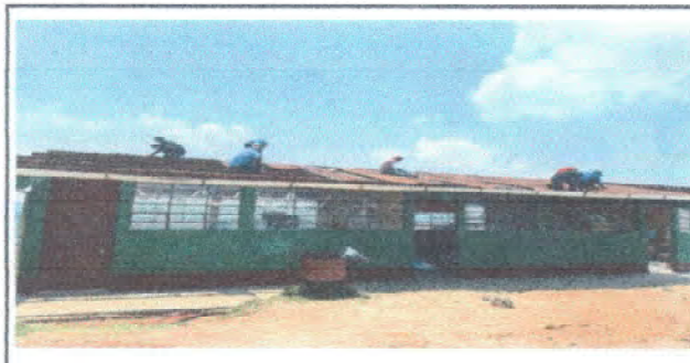
Foto 6: trabajando la cubierta de lamina para el cambio de techo de la escuela.
