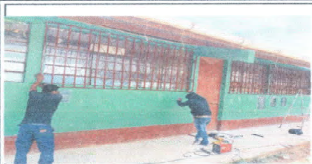
Foto1: Instalacion de balcones para ventanas de la escuela
