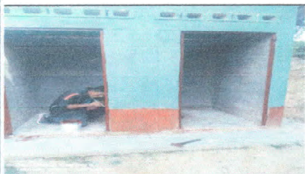
Foto 3: instalacion de puertas para servicio sanitario de la escuela.
